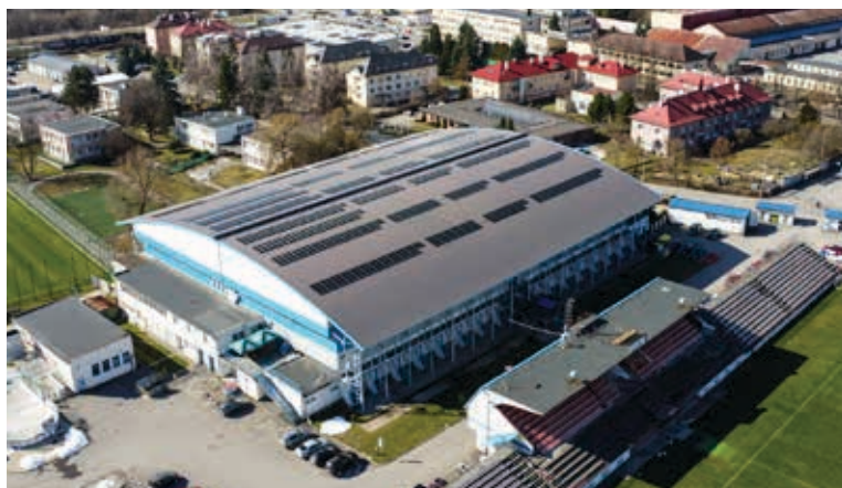
FOTOVOLTIKA NA ZIMNOM ŠTADIÓNE
